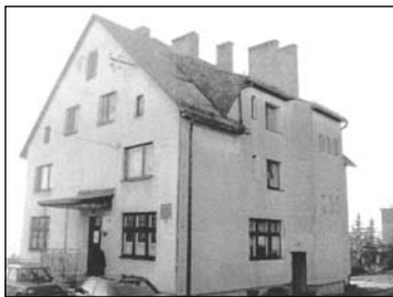
Przed rozpoczęciem prac
