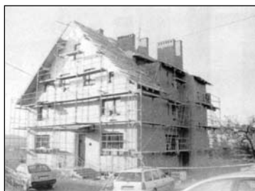
W trakcie realizacji
