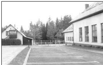
Droga i parking po zakończeniu prac
