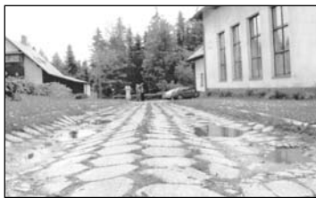
Stan przed rozpoczęciem prac
