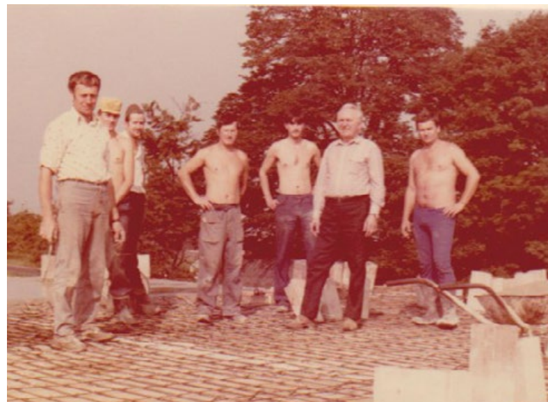
> Budowa strażnicy OSP w Koniakowie, 17.08.1984 r.
