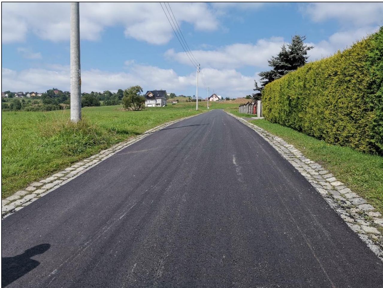
Fotografia 15.6 Remont drogi gminnej Łacki–Czadeczka w Jaworzynce
