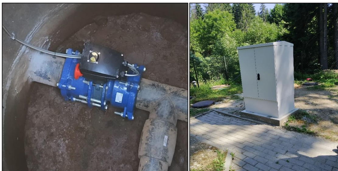
Fotografia 5.1.5 Po lewej: system automatycznych zasuw; Po prawej: szafa sterująca ujęciem wody z rzeki Olzy.
