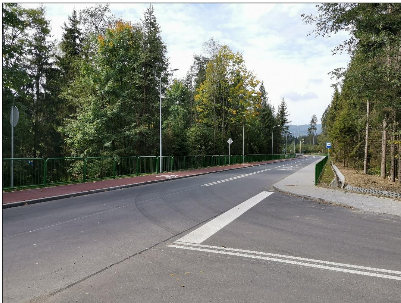
Fotografia 15.5 Zakończona rozbudowa drogi wewnętrznej Zaolzie etap II
