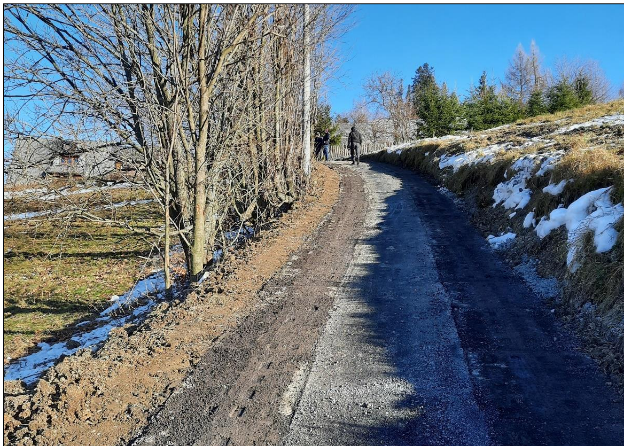
Fotografia 15.4 Zakończenie prac remontowych drogi gminnej „Na Wyrszczek”
