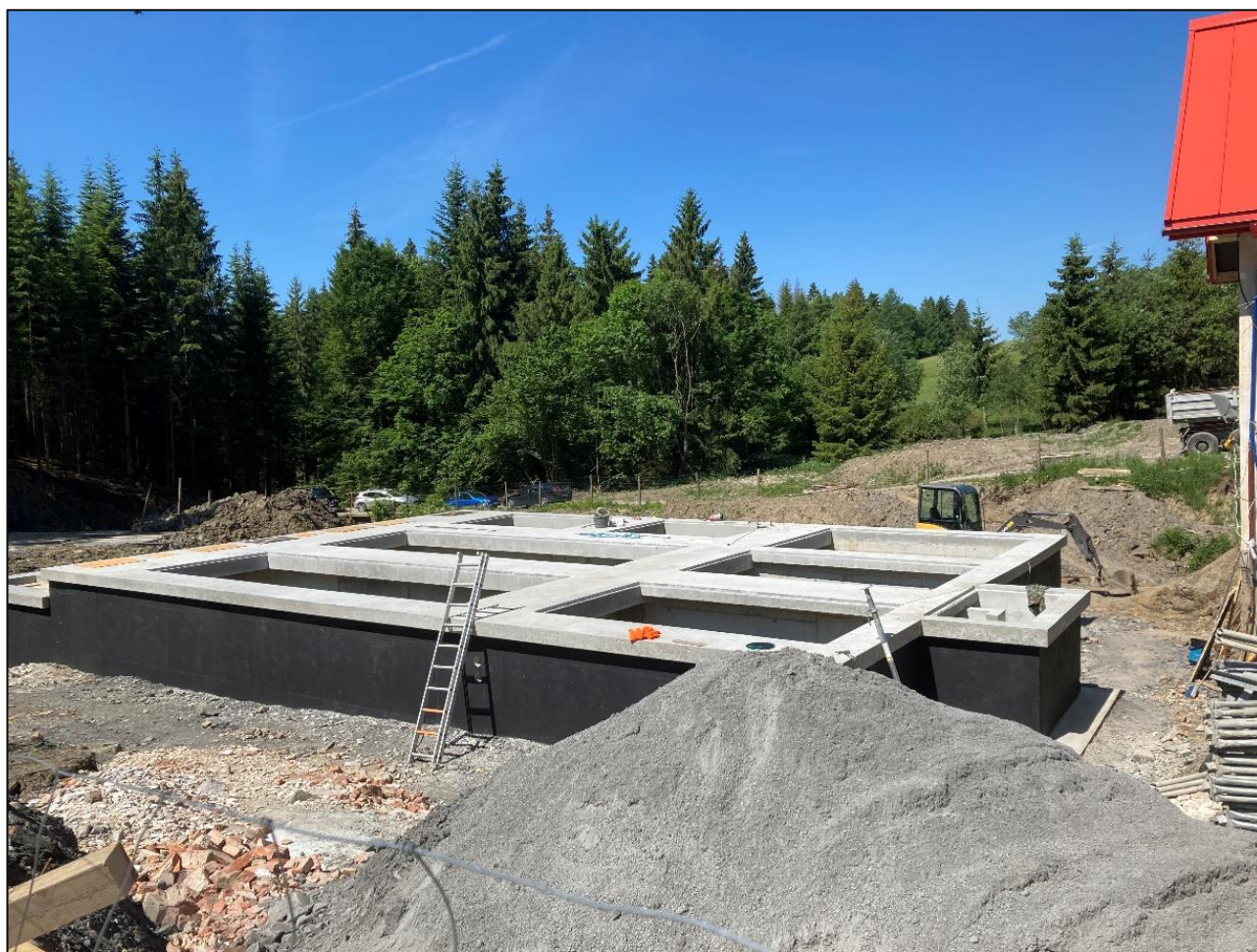
Fotografia 15.1 Trwające prace w ramach przebudowy oczyszczalni ścieków Pustki w Koniakowie
