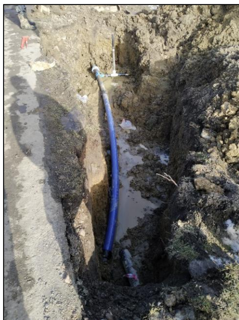
Fotografia 5.1.2 Prace nad wymianą awaryjnej sieci wodociągowej Koniaków Gronik. Wykop z wymienionym odcinkiem sieci wodociągowej DN 100 PE RC.
