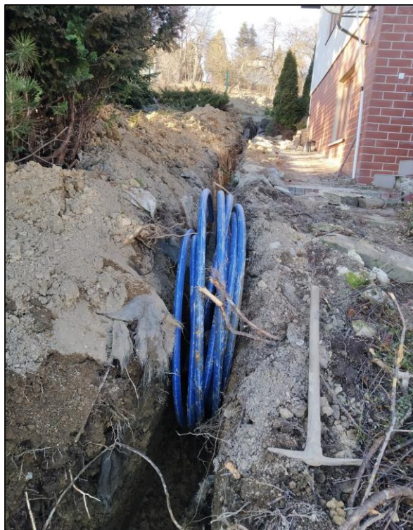
Fotografia 5.1.1 Prace nad wymianą awaryjnej sieci wodociągowej Istebna Gazury. Wykop z umieszczoną w nim rolką nowej rury DN 40 PE RC.
