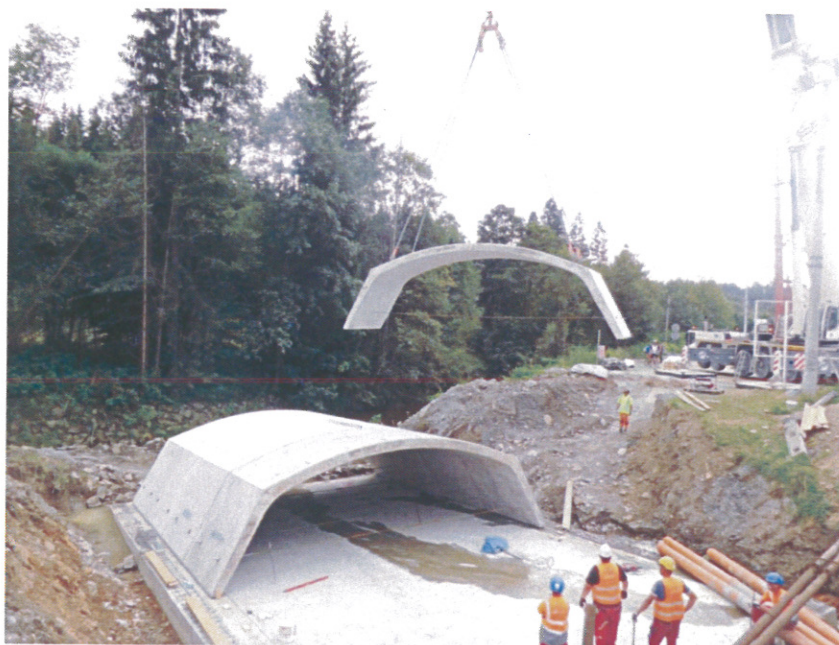
Zdjęcie: Montaż prefabrykatów na potoku OLECKA.
