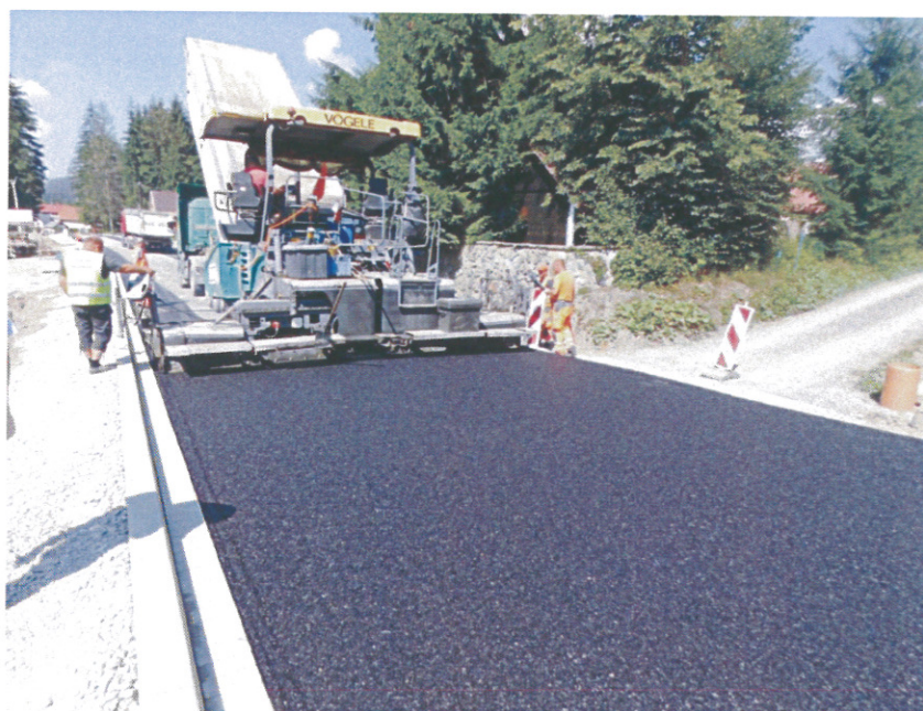
Zdjęcie: Roboty związane z układaniem warstwy wiążącej.
