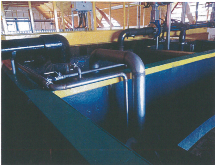
Zdjęcie: Reaktor biologiczny nr 2 po przeprowadzonym remoncie
